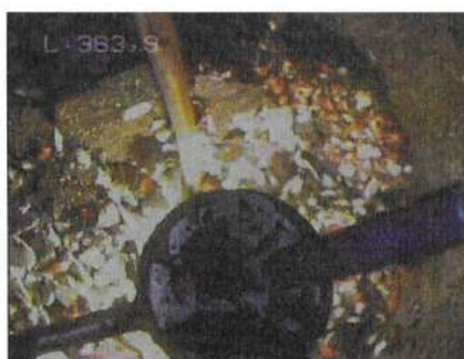
Obstruction de la colonne à 383,9 m
